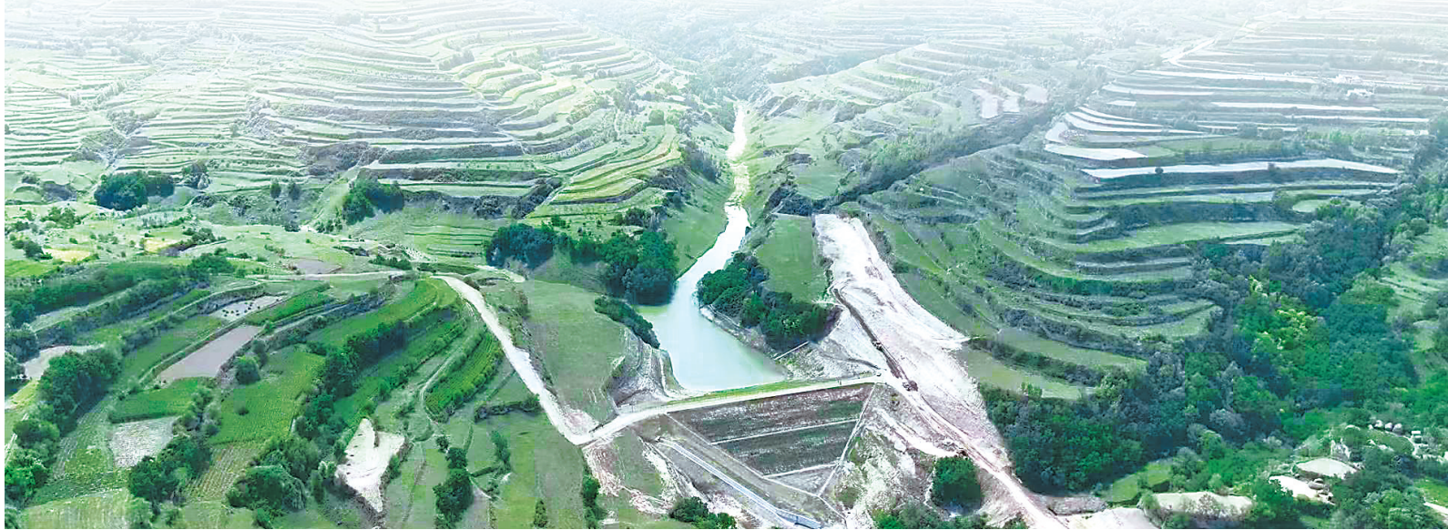
庄浪县柳梁镇下岔村陈家新庄淤地坝。
