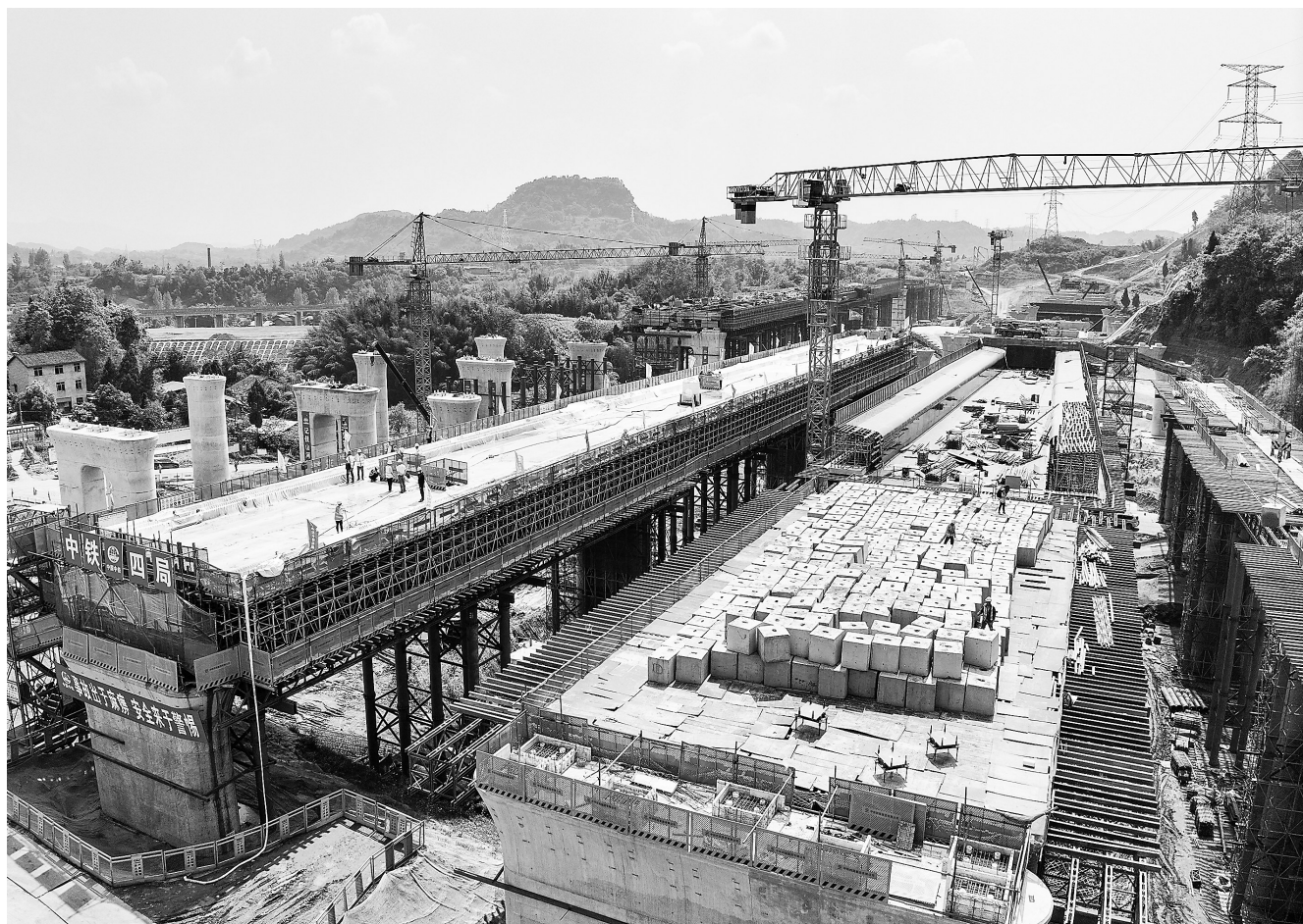
4月14日,位于四川省达州市境内的达州南站2号八线特大桥连续梁建设现场一派繁忙景象。当日,西渝高铁康渝段全线首联连续梁顺利完工,为后续连续梁施工奠定了基础。新华社记者 王曦
