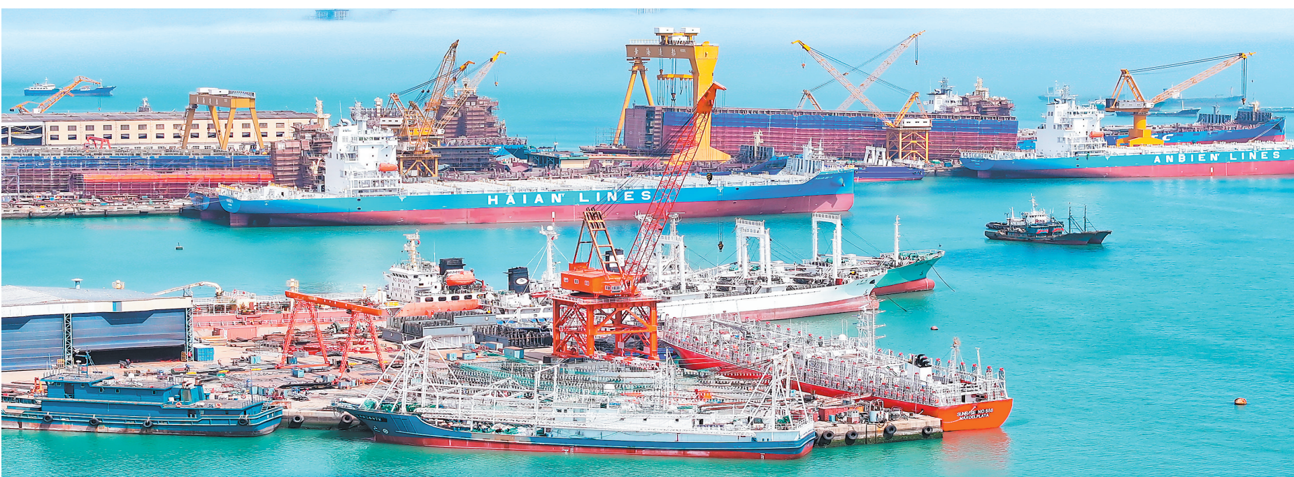
4月13日,山东省荣成市石岛管理区修造船产业基地内,大型船舶建造、维修正酣。今年一季度,荣成市修造船企业出口船舶货值4.9亿元,同比增长33.6%。
