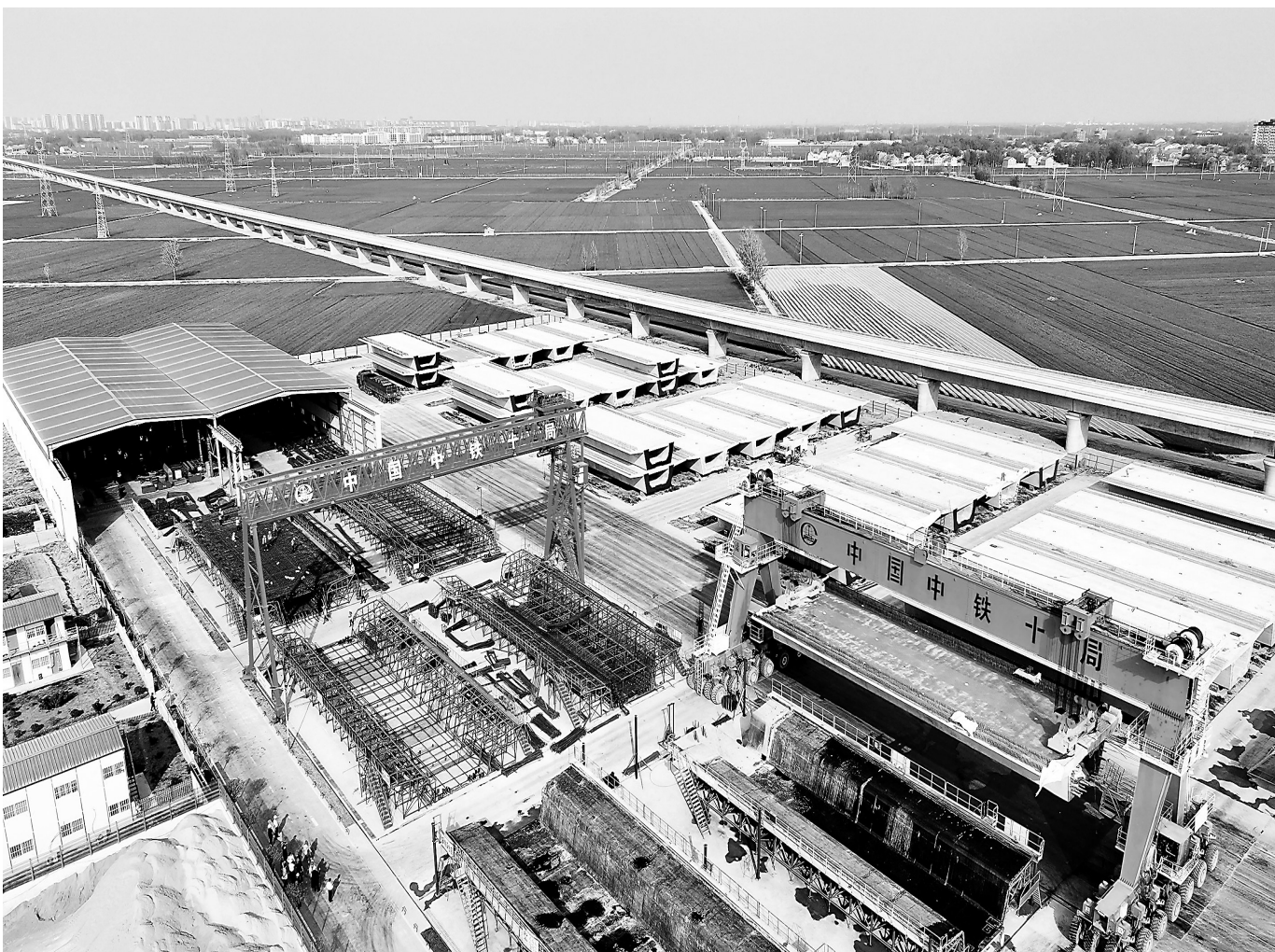
在雄商高铁山东菏泽段中铁十局双桥制梁场,工作人员在制作箱梁(4月12日报)。国家重点工程雄(安)商(丘)高铁山东菏泽项目承建方抢抓工期与节点,段箱梁预制、箱梁架设等工作正有序推进。 新华社记者 郭绪雷
