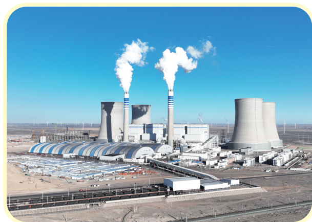
甘肃电投集团投资建设的总装机6台100万千瓦的常乐电厂。
