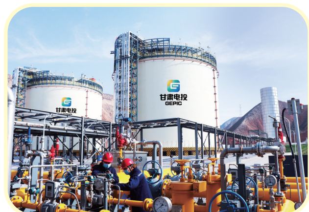
甘肃电投集团投资建设的兰州天然气应急保障项目。
