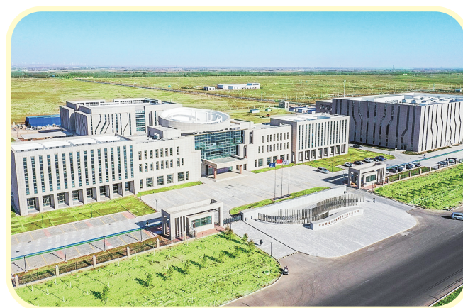
甘肃电投集团金昌紫金云大数据产业园。
