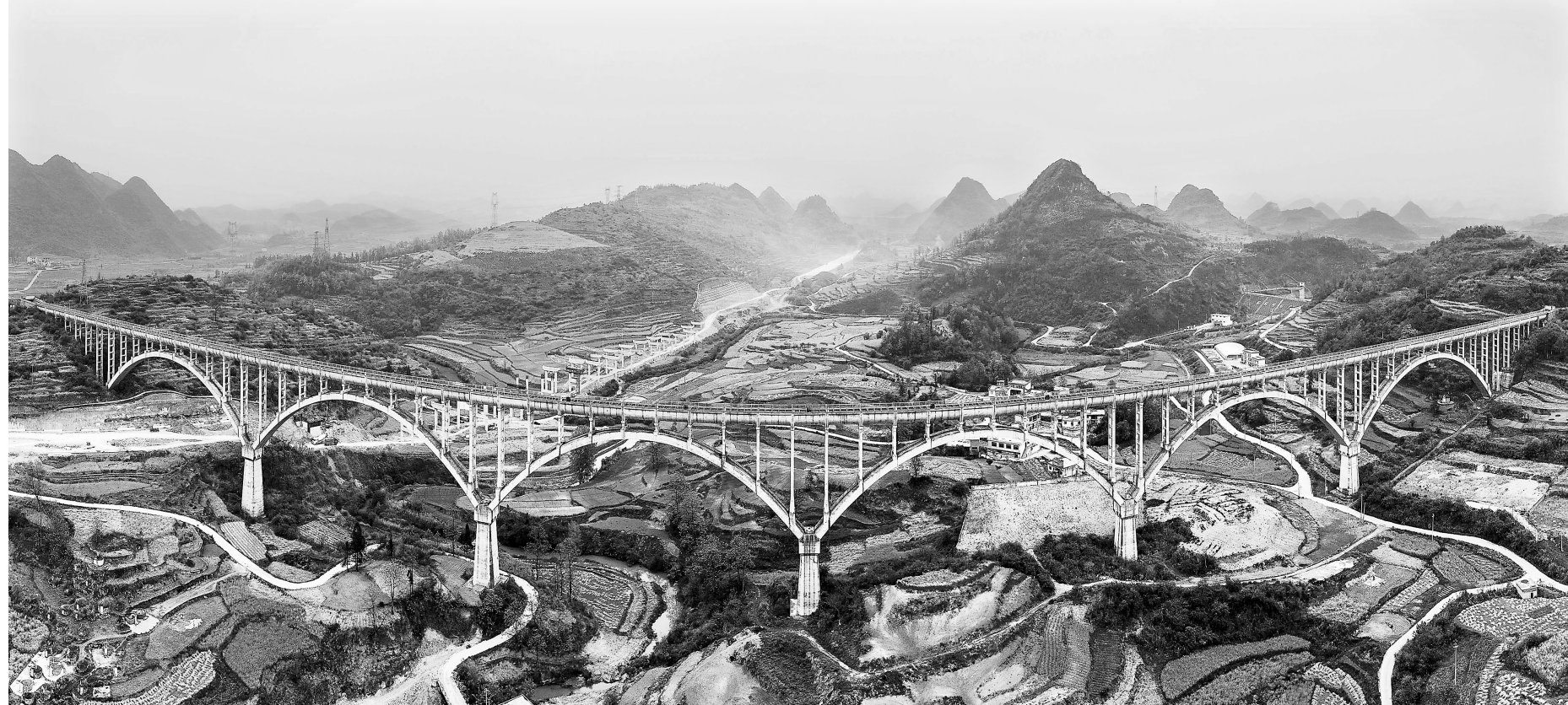
这是贵州省黔中水利枢纽一期工程青年队渡槽(4月9日摄)。近年来,贵州省加快推进骨干水源、农村供水等工程建设,全省水安全保障能力不断提升。 新华社记者 杨文斌
