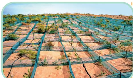
民勤县沙咀墩精准固沙造林区的尼龙网沙障方格。
