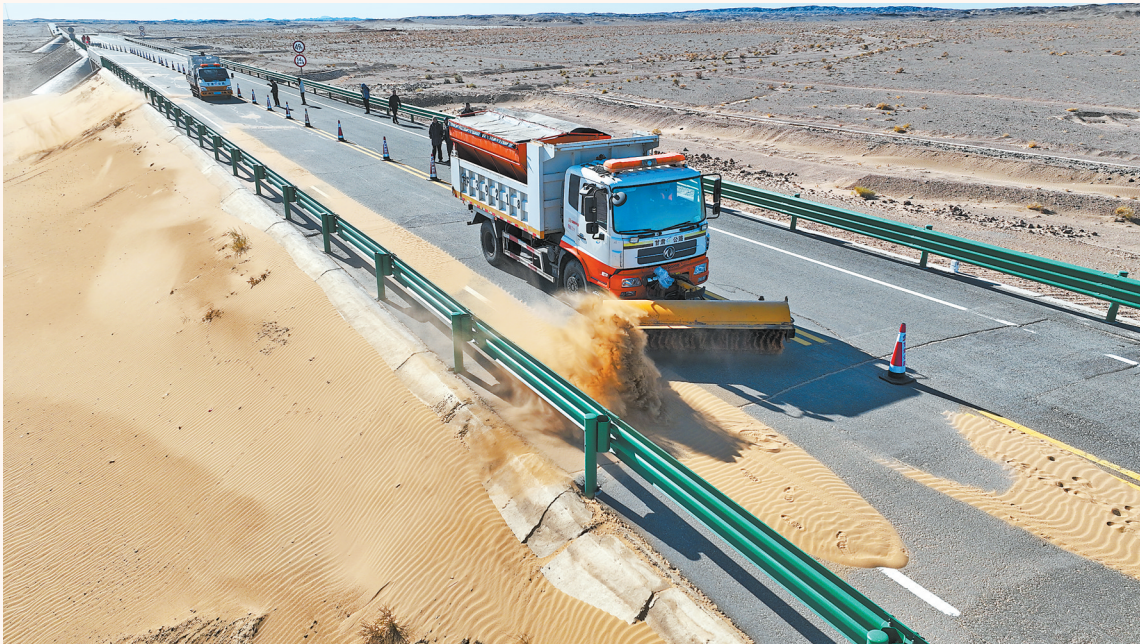
马鬃山养路人在公路上除沙。 新甘肃·甘肃日报通讯员 张兆缘
