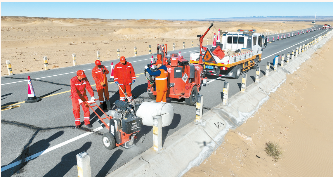
马鬃山公路段职工在国道215线进行补缝作业。 新甘肃·甘肃日报通讯员 张兆缘
