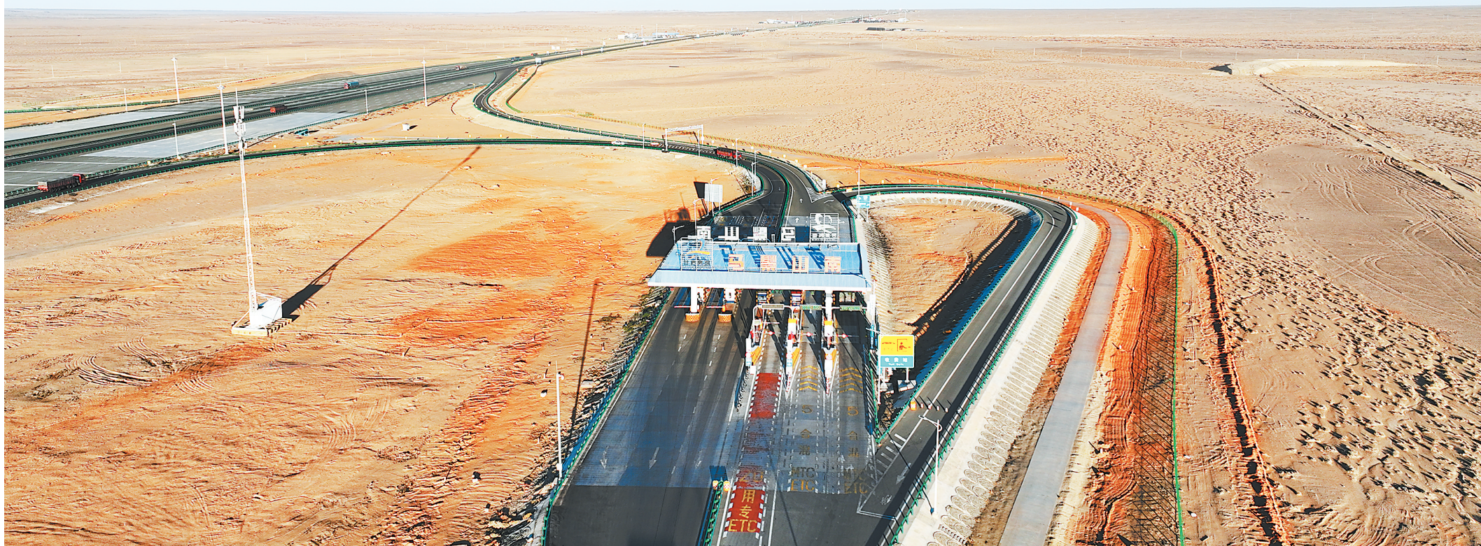
G7京新国家高速公路马鬃山出入口。
