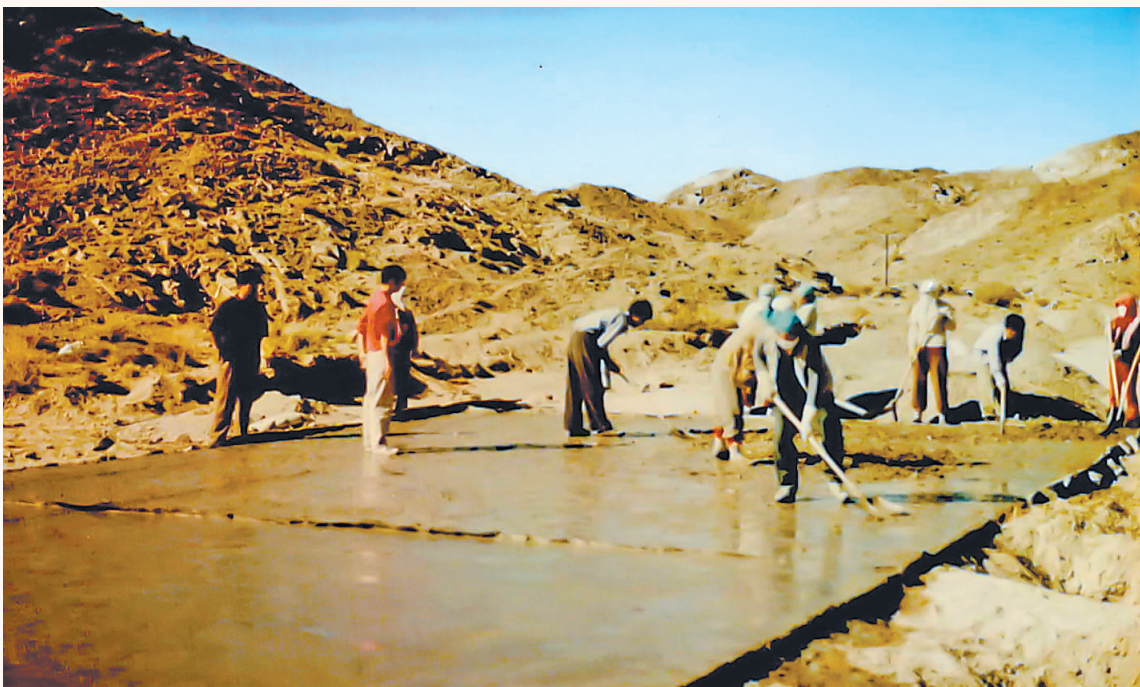
1991年,马鬃山养路人维修过水路面。(资料图)
