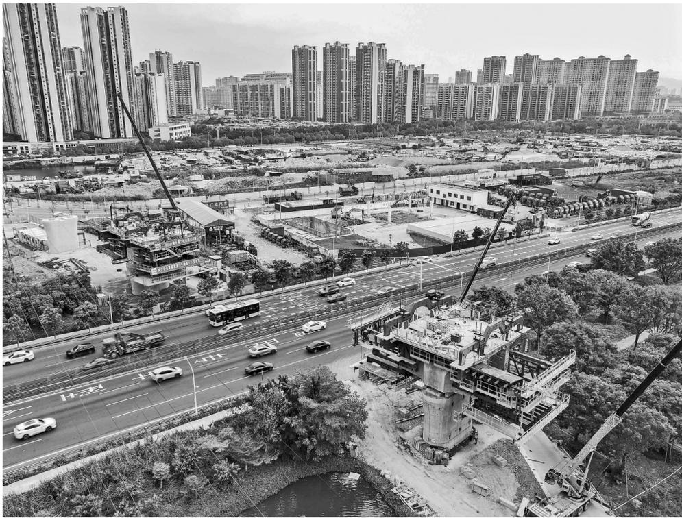
3月31日,中铁建大桥局运用全线首台多功能悬臂智慧造桥机,浇筑完成深江铁路跨105国道沙漠特大桥首节连续梁。对比传统挂篮悬臂浇筑施工,智慧造桥机有效降低高空作业的安全风险,并提高拼装效率。
