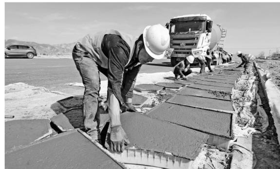
近日，中铁二十局市政公司工人在兰州生态创新城生态大道预制边坡防护骨架。该主干道建设项目对完善兰州生态创新城周边交通具有重要意义。
