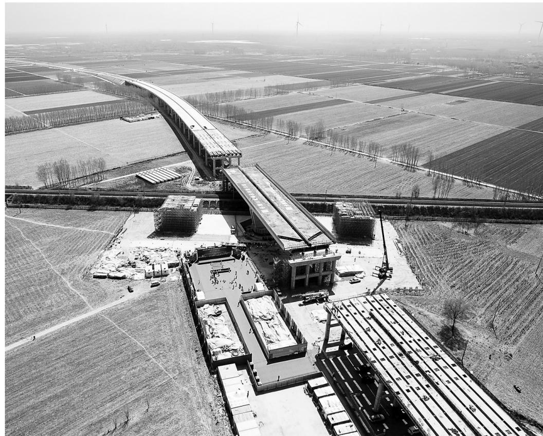
3月31日,上跨黄铁路分离式立交桥完成转体。当日,在位于河北省衡水市武邑县西桑村附近的邯鄹至黄骅港高速公路衡水段项目工地,上跨黄铁路分离式立交桥历时70分钟完成70度转体。新华社记者 任丽颖
