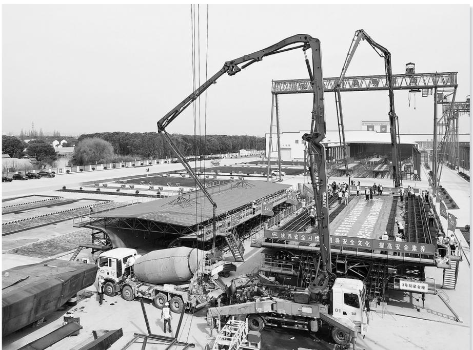
3月30日,沪渝蓉高铁沪宁段首榀箱梁在位于上海的宝慧制梁场顺利浇筑完成。此次浇筑的箱梁长32.6米、跨度31.5米,设计重量790.3吨。首榀箱梁的成功浇筑,标志着梁场正式进入箱梁预制生产阶段。新华社发
