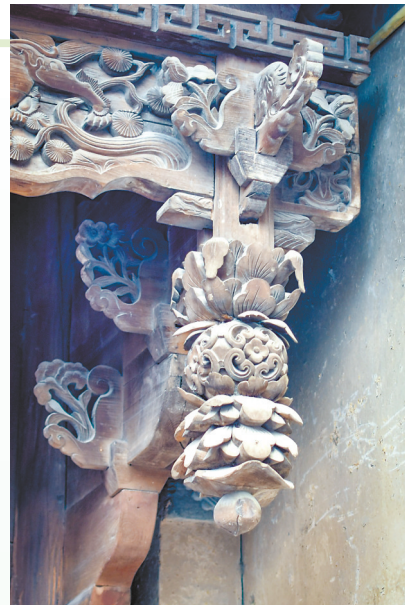
庭院内的建筑木雕
