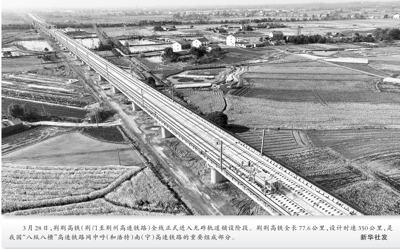
3月28日,荆荆高铁(荆门至荆州高速铁路)全线正式进入无砟轨道铺设阶段。荆荆高铁全长77.6公里,设计时速350公里,是我国“八纵八横”高速铁路网中呼(和浩特)南(宁)高速铁路的重要组成部分。新华社发
