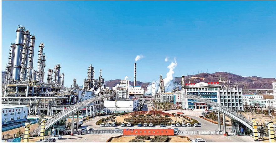
华亭市60万吨煤制甲醇公司全貌。
