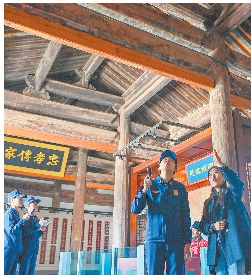
检查古建筑内的供电线路。
