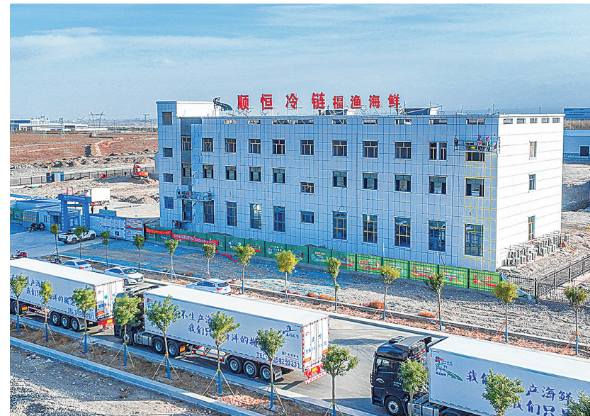
建设中的嘉峪关顺恒智慧冷链物流园。
