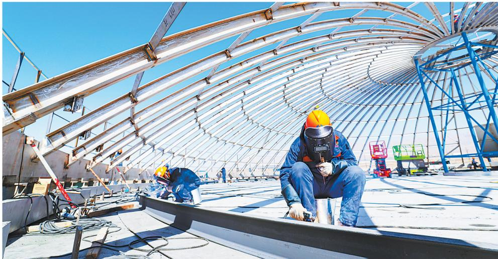
3月19日,位于山丹县东乐镇的张掖LNG储备中心二期项目2.98万立方米储罐建设现场,建设者们正在进行储罐顶部的钢结构焊接。
