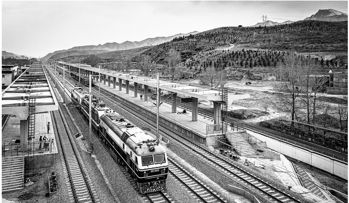
3月16日,一台试验车从兰张三四线铁路兰武段武威东站出发,重点对正线、分相、线岔等接触网关键设备的静态参数状态进行检测,这标志着兰张高铁兰武段接触网工程冷滑试验正式开始,为下一步热滑试验及联调联试工作奠定基础。
