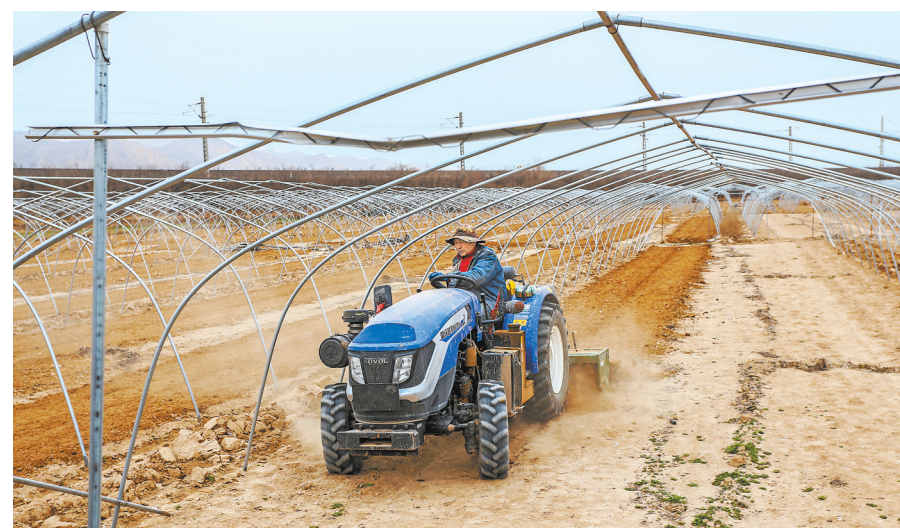
平凉市崆峒区四十里铺镇张村西瓜种植基地,瓜农们正在翻地、搭棚。 新甘肃·甘肃日报通讯员 郑 兵
