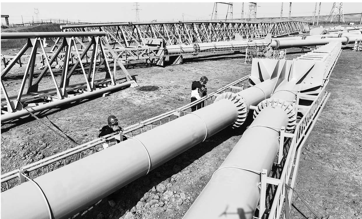
近日,在全塔750千伏输电工程配电装置区,工人正在为构架喷涂防腐涂料并紧固螺栓。新甘肃·甘肃日报通讯员 曹红祖
