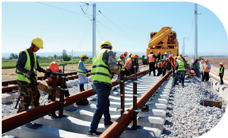
2023年8月,兰张三四线铁路武威段铺轨作业现场。金奉乾
