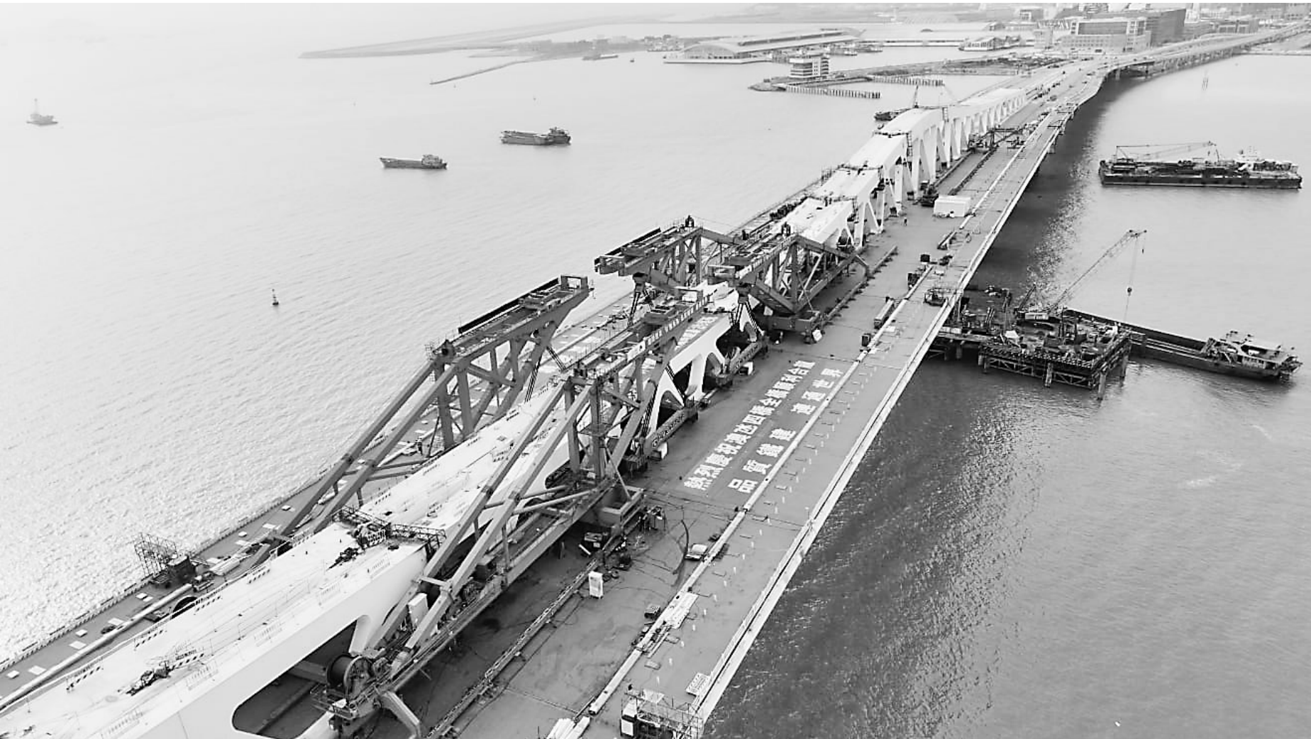
3月12日拍摄的澳门半岛至氹仔的第四条跨海大桥。澳门半岛至氹仔的第四条跨海大桥12日晚顺利实现全桥合龙,标志着项目由主体结构工程全面迈入桥梁附属结构工程。 新华社发
