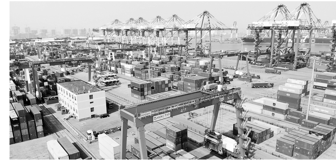
图为山东港口青岛港前湾集装箱码头。近日，青岛海关发布数据显示，今年前2个月，青岛市外贸进出口1258亿元人民币，同比增长5.4%。
