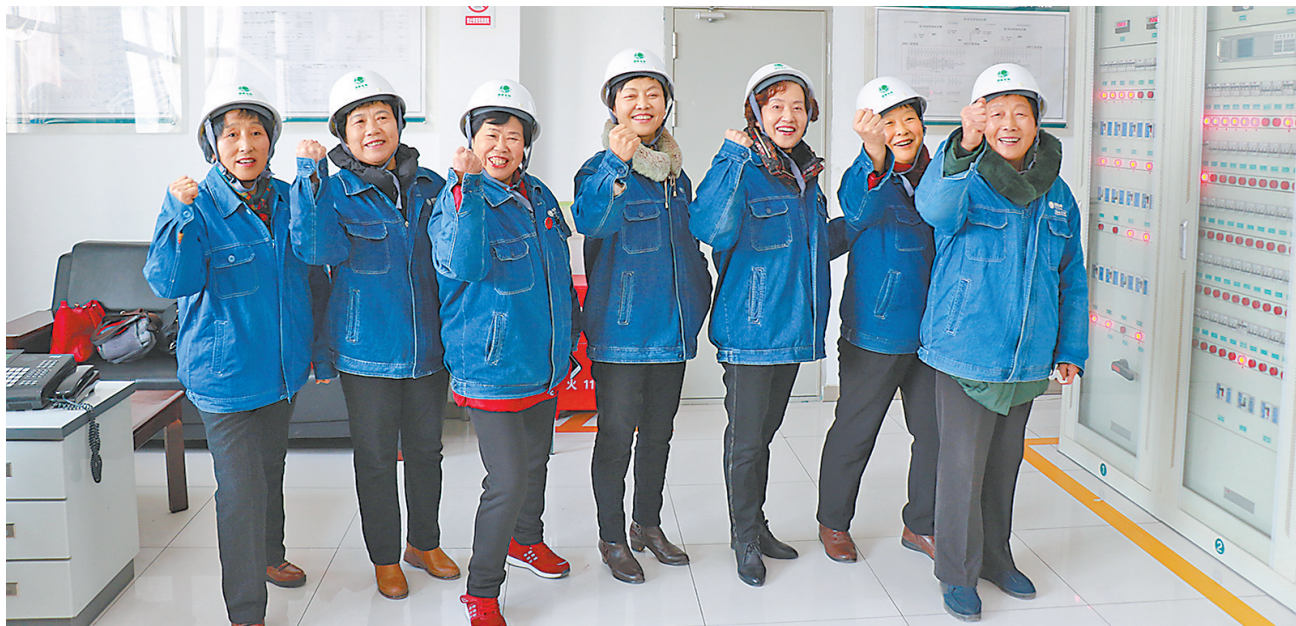
2020年,七姐妹在330千伏秦安变电站再聚首。
