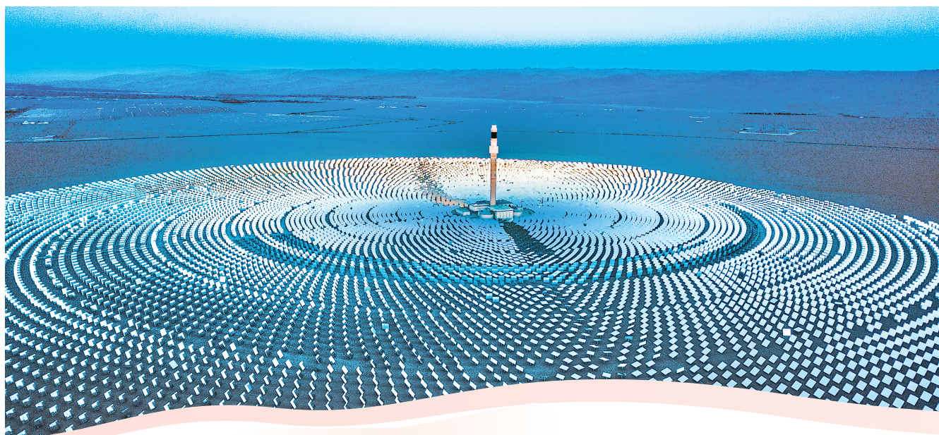
甘肃敦煌100兆瓦熔盐塔式光热发电站。新甘肃·甘肃日报通讯员 王斌摄
