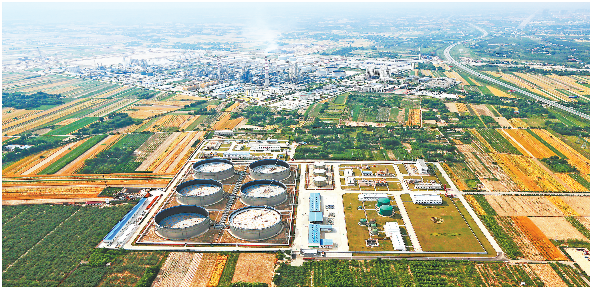
中国石油庆阳石化公司300万吨炼油搬迁改造项目。
