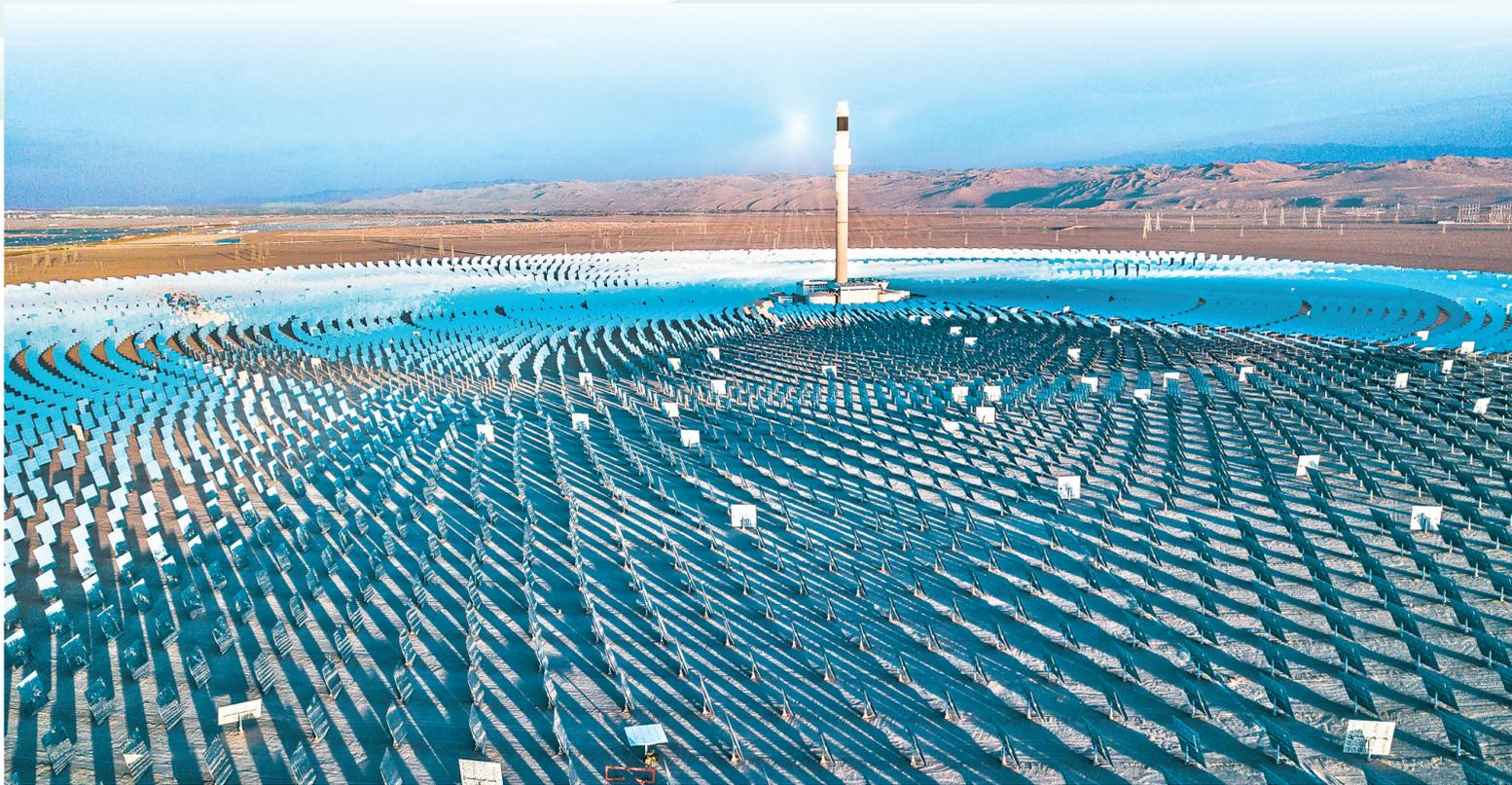
敦煌光电产业园区内的熔盐塔式光热发电站。
