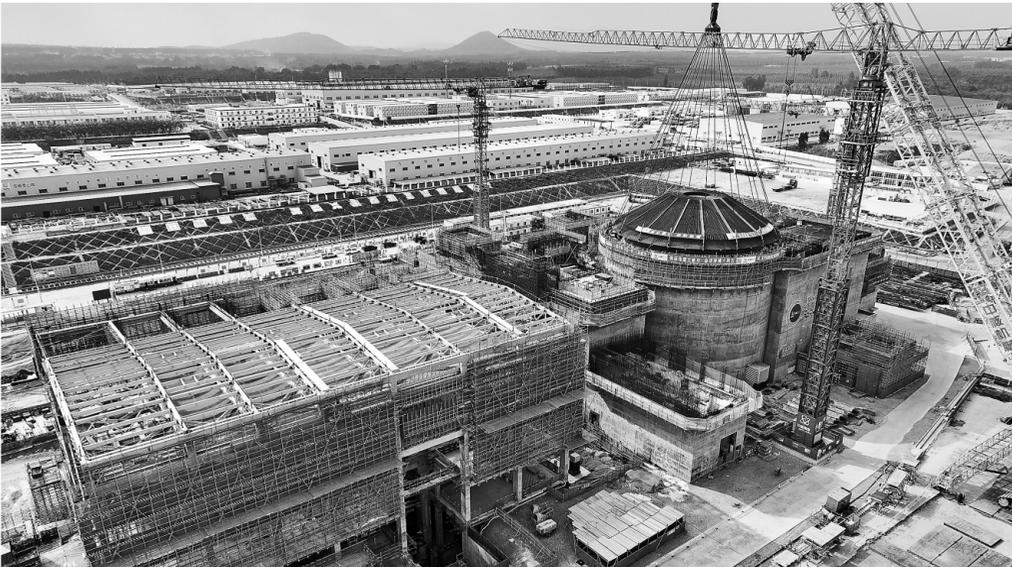
2月6日,海南昌江核电厂多用途模块化小型堆科技示范工程“玲龙一号”外穹顶在进行吊装作业。据了解,“玲龙一号”是全球首个开工建造的陆上商用多用途模块化小型压水堆,是中核集团继“华龙一号”后我国核电自主创新的又一重大成果。 新华社发
