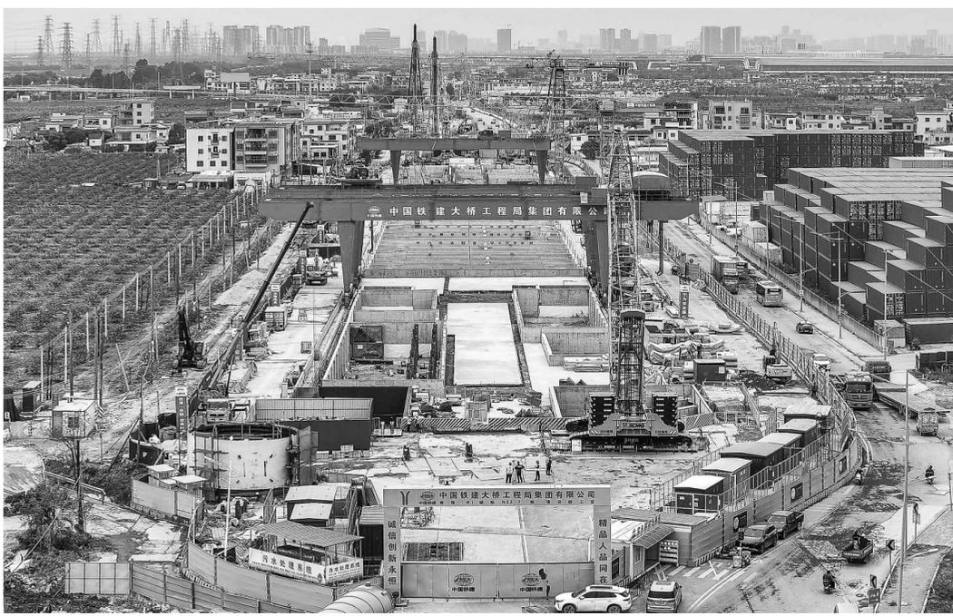
南珠(中)城际十涌站车站和盾构井施工现场(2月5日摄,无人机照片)。春节前,中铁建大桥局承建的广州南沙至珠海(中山)城际十涌站至十三涌站区间两台盾构机正在紧张有序地装配调试。南珠(中)城际建成后中山市与广州市中心将实现45分钟通达,对打造“轨道上的大湾区”、促进广州都市圈和珠江西岸都市圈深度融合具有积极意义。
