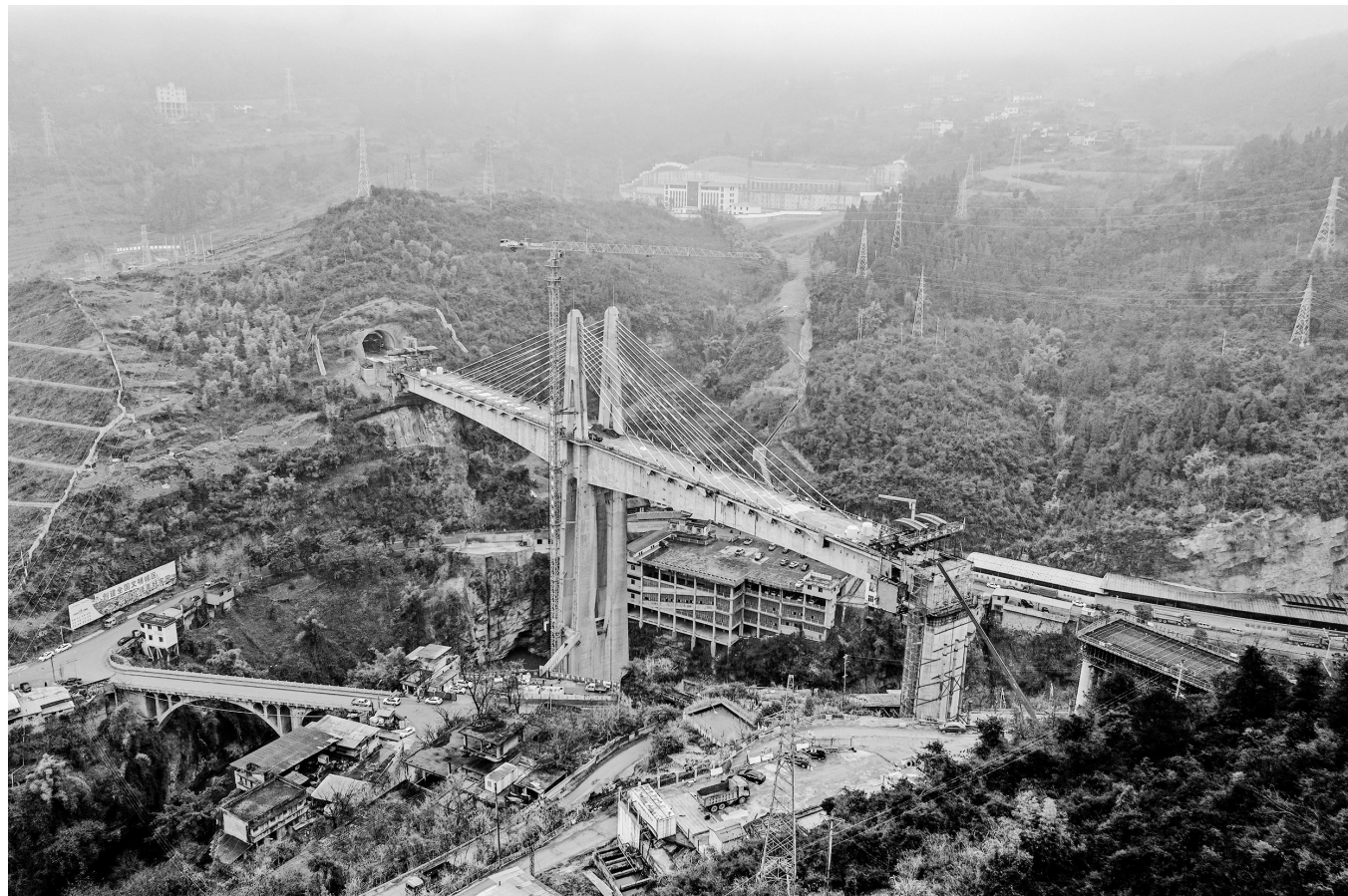
1月31日,渝湘高铁长途河双线大桥顺利合龙,图为渝湘高铁长途河双线大桥施工现场。
