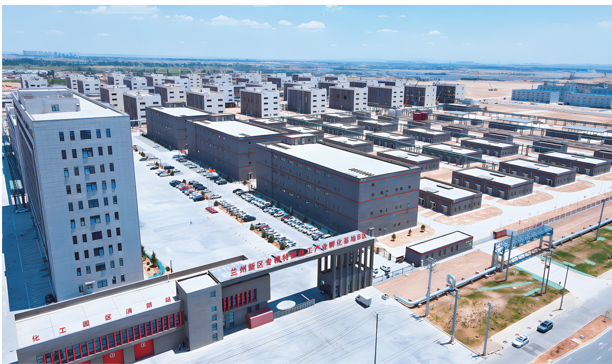
兰州新区专精特新化工产业孵化基地。
