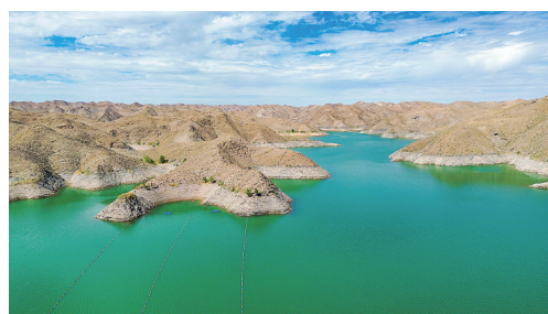
引大入秦工程兰州新区供水项目石门沟水库。
