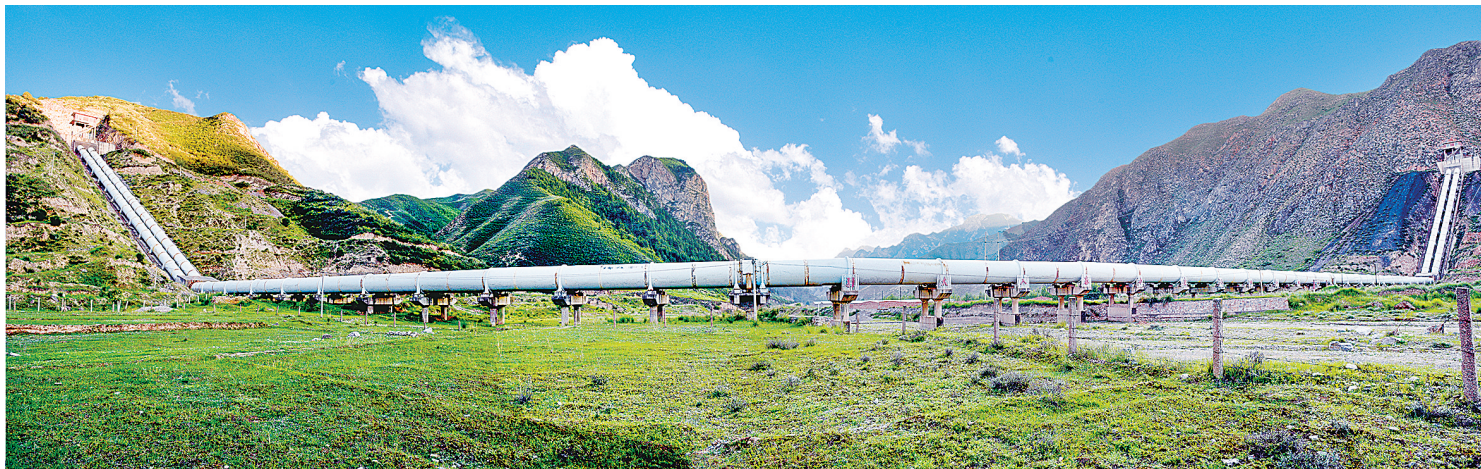
引大入秦工程总干渠水磨沟倒虹吸。
