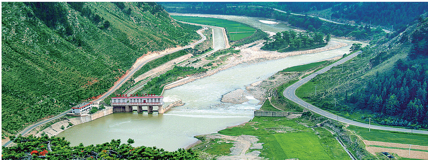
风光旖旎的引大入秦工程渠首引水枢纽。
