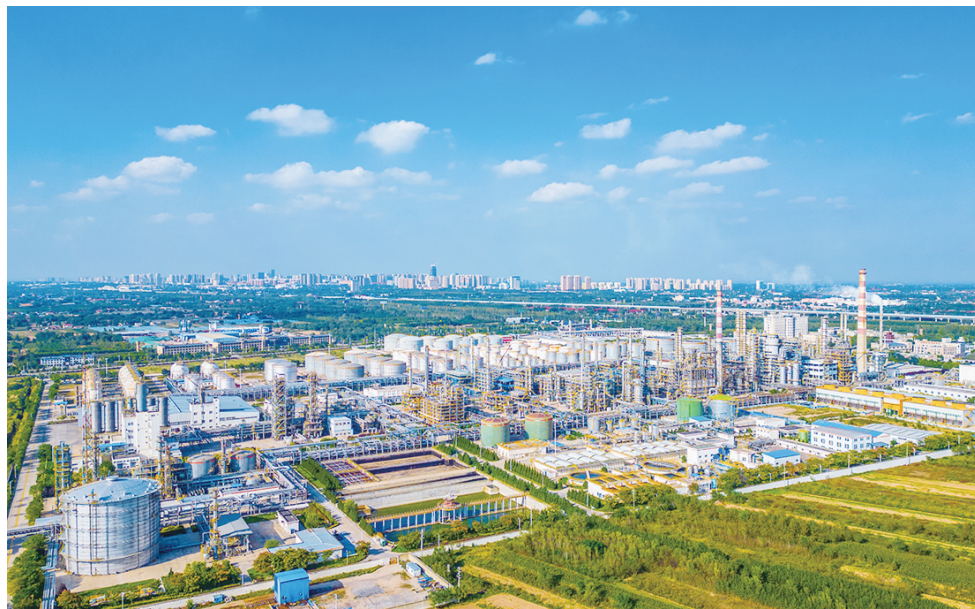
庆阳市西峰工业园区石化产业区。陈飞
