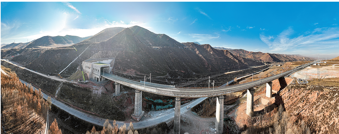
兰张三四线铁路新马岭隧道。
