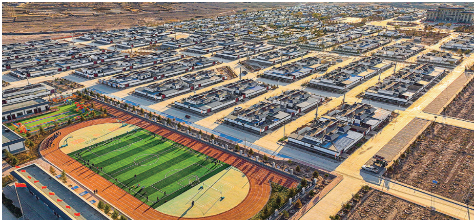
凉州区金山镇生态及地质灾害避险搬迁项目。
