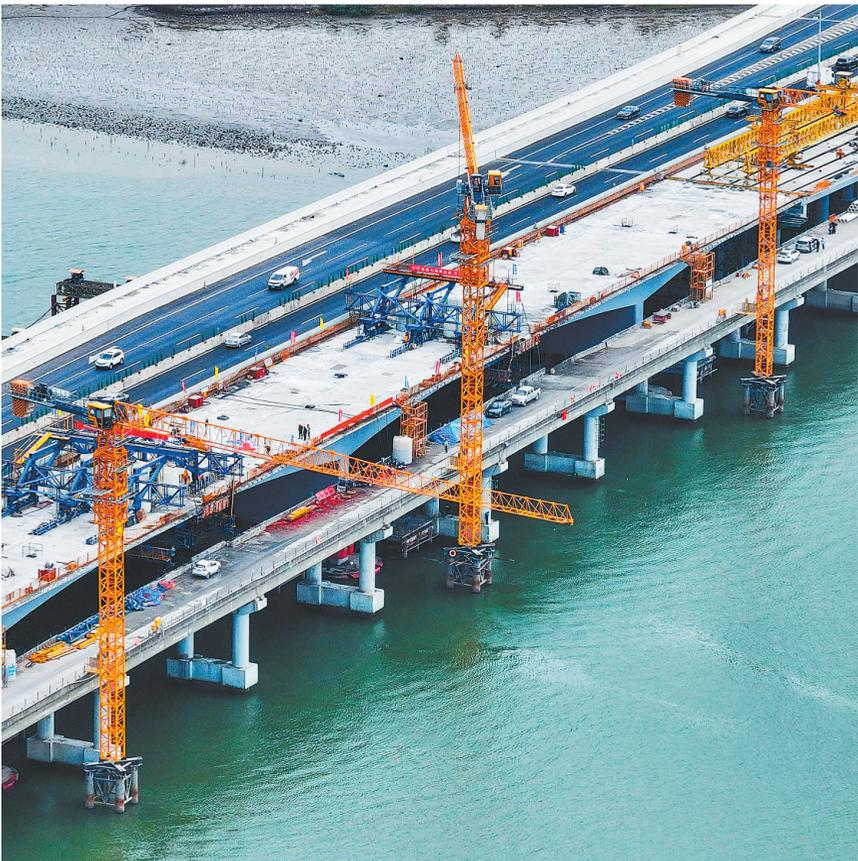
1月21日,深汕西高速改扩建项目长沙湾跨海特大桥左幅主跨合龙。作为沈海国家高速公路汕尾陆丰至深圳龙岗段的深汕西高速改扩建项目全长约146公里。长沙湾跨海特大桥是项目全线控制性工程,桥梁全长2108米,采用先建新右幅新桥,再拆除既有特大桥重建左幅的施工方式,大桥右幅已于2023年3月22日建成通车。
