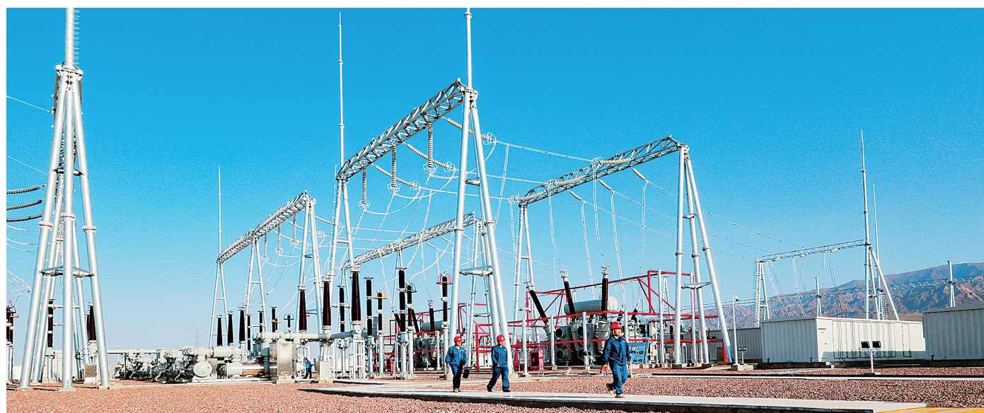
工人在山丹县东乐北滩330千伏汇集站检查检修。
