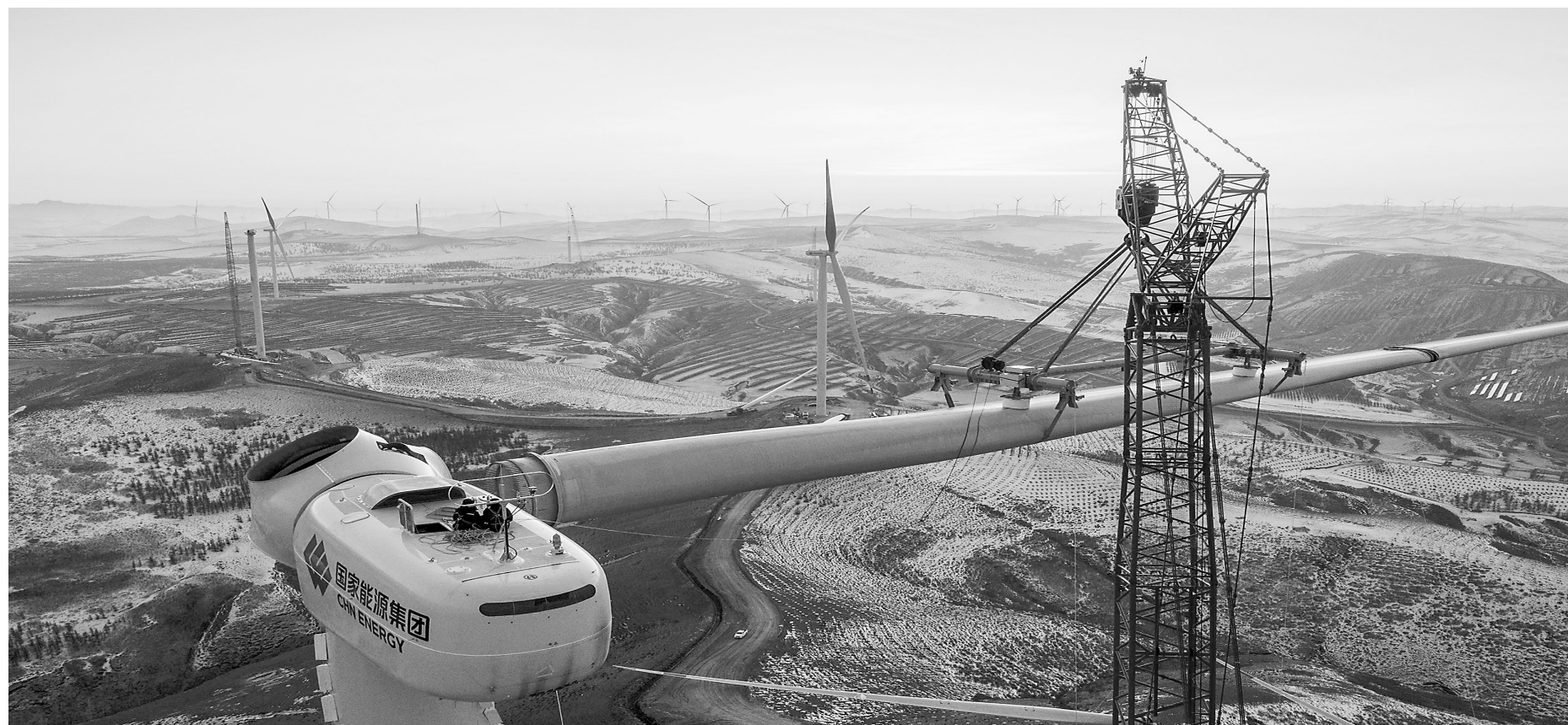
1月12日,在承德丰宁风光氢储100万千瓦风光项目施工现场,工人在吊装风机扇叶。该项目是国家“十四五”规划的大型清洁能源基地——冀北清洁能源基地的标志性工程。新华社发
