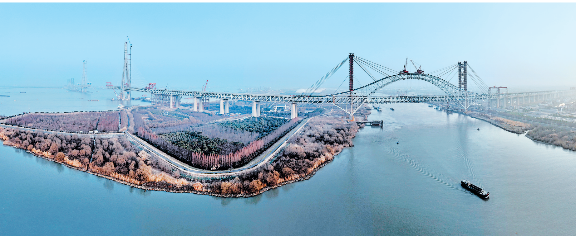
1月12日拍摄的位于江苏省常州市的常泰长江大桥梁洲专用航道桥(无人机照片)。当日,由中铁大桥局承建的常泰长江大桥梁洲专用航道桥顺利合龙。常泰长江大桥连接江苏省的常州市与泰州市,是一座集高速公路、城际铁路、普通公路于一体的过江通道。
