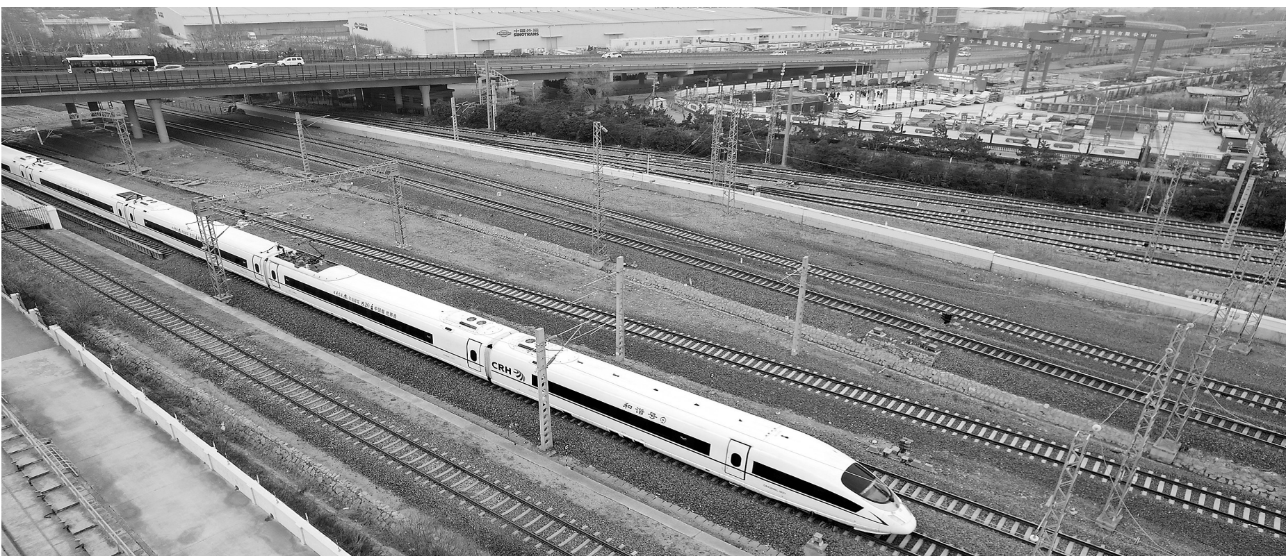
一列动车从建设中的青岛地铁5号线瑞昌路站附近驶过(1月9日摄,无人机照片)。当日,在中铁十四局承建的青岛地铁5号线瑞昌路站至湖岛站区间施工现场,盾构机成功下穿胶济铁路8股正在使用中的铁轨线路,为国内地铁建设盾构下穿复杂铁路网积累了经验。
