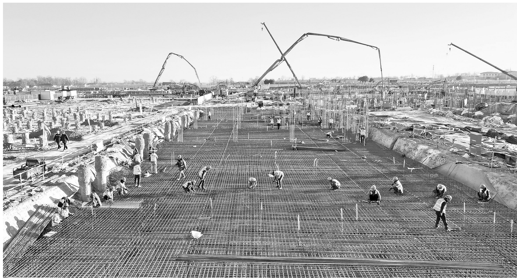
近日,在位于庆阳市西峰区社乡的陇东—山东±800千伏特高压直流输电工程庆阳换流站项目建设现场,施工人员抓紧作业,确保工程完成阶段任务。
