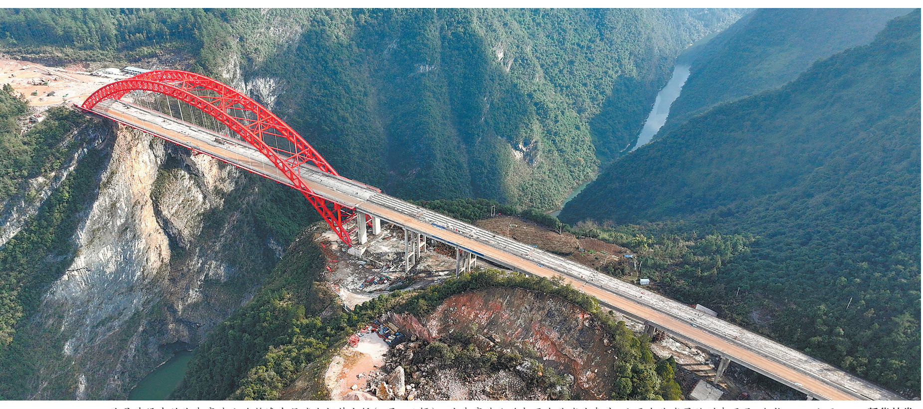
这是建设中的宜来高速公路鹤峰东段涪陵水河特大桥(1月8日摄)。宜来高速公路起于湖北省宜都市,止于湖北省恩施州来凤县,全长187.7公里。 新华社发
