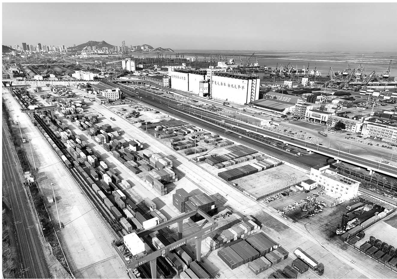
1月8日拍摄的中哈(连云港)物流合作基地装卸作业区。新年伊始,江苏连云港中欧班列有序装卸作业,全力冲刺首月“开门红”。
