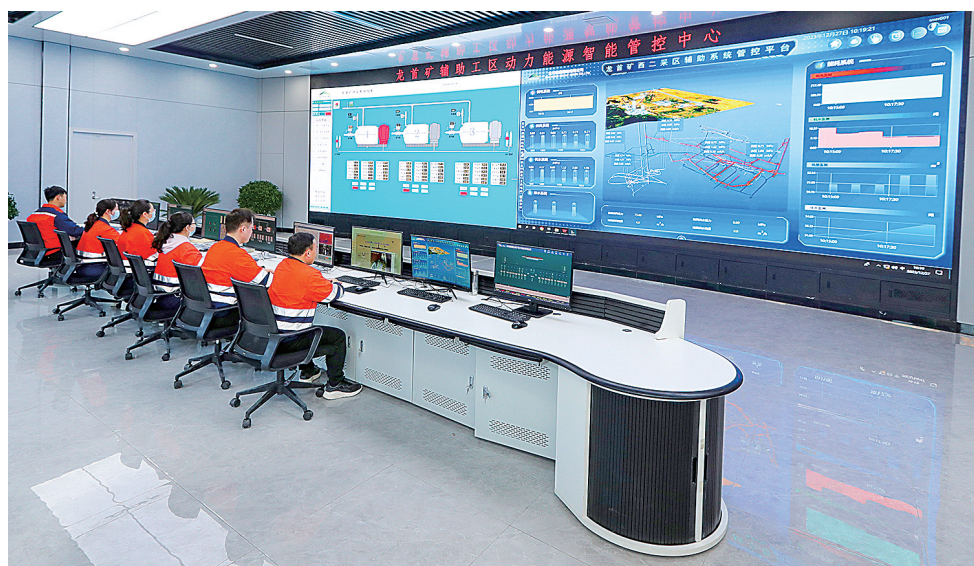
金川集团龙首矿辅助工区动力管控中心。张俊成
