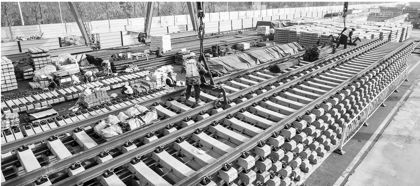
1月6日,在长沙地铁2号线西延段铺轨工地,中铁五局工人操作龙门吊吊装轨排。长沙地铁2号线西延段正在进行正线轨道铺设施工。项目建成后,将连通长沙南站与长沙西站,旅客坐地铁就能实现两座高铁站之间换乘。
