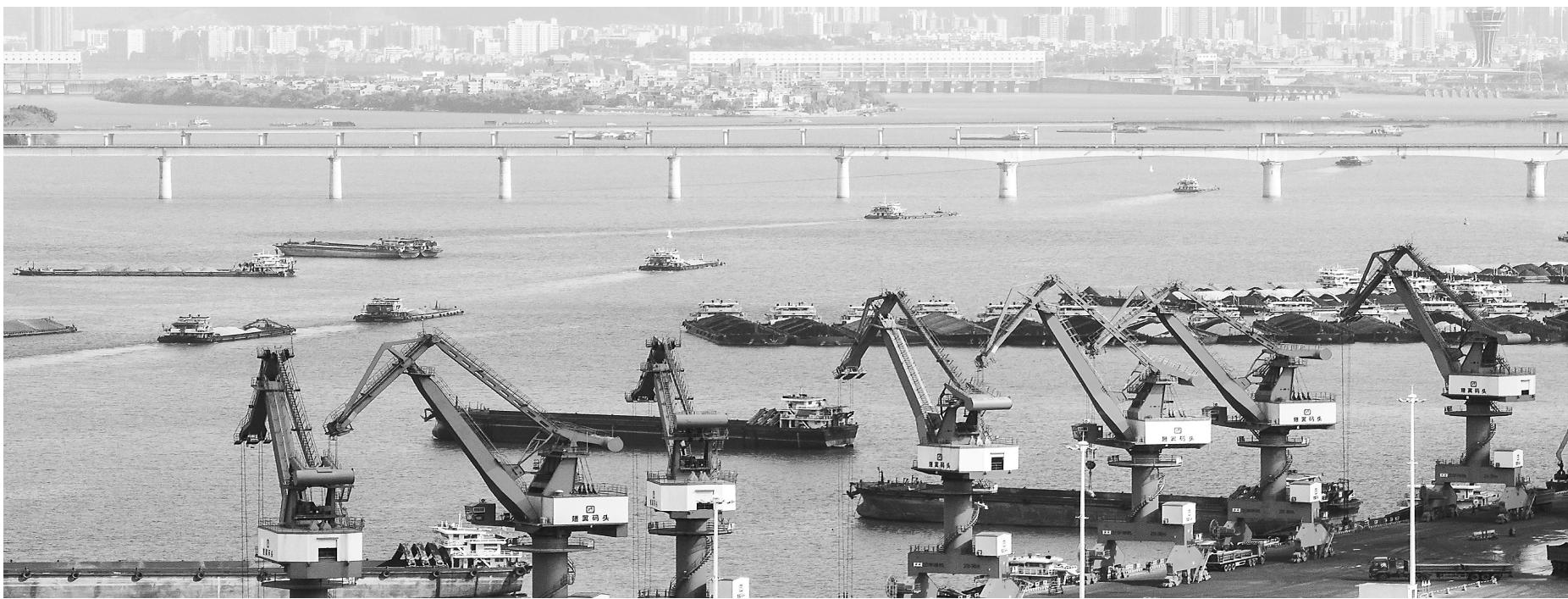
1月3日,在广西梧州临港经济区赤水港码头,工人操作设备在码头上进行装卸作业。新年伊始,各大港口货轮进出,各作业码头运输车辆穿梭如织,货物进出繁忙。 新华社发
