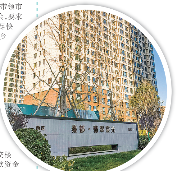
秦都·翡翠宸光项目建设现场。
