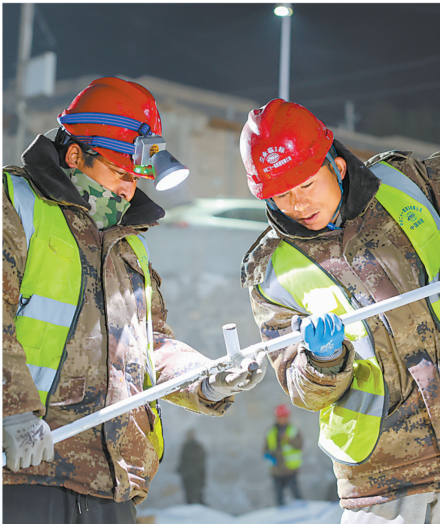
在积石山县大河家镇集中安置点,中铁二十一局工作人员正在施工。连日来,中铁二十一局抗震救灾前方指挥部严格按照各安置点现场设计方案进行安置板房建设。新甘肃·甘肃日报记者 冯乐凯 田蹊
