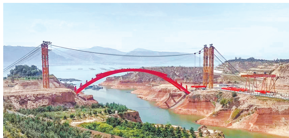
中铁二十一局承建的永靖县刘家峡太阳岛至魏家坡道路景观特大桥。 新甘肃·甘肃日报通讯员 周鹏
