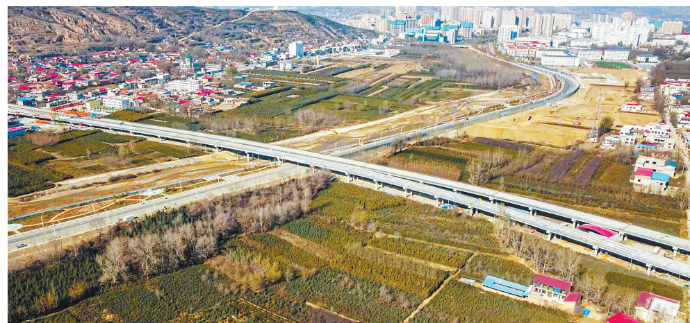
中铁二十一局承建的临康广高速公路胭脂河大桥。 新甘肃·甘肃日报通讯员 李扬
