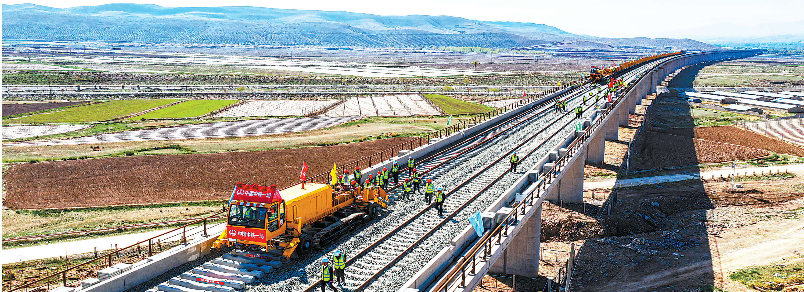
2023年5月26日,位于天祝县境内的兰州至张掖三四线铁路下河东特大桥施工现场。
